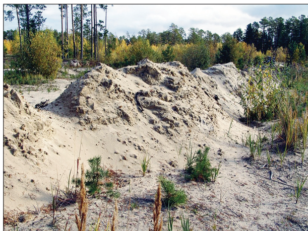
Рис. 1. Насыпной песчаный вал на суходоле без трубопровода.
