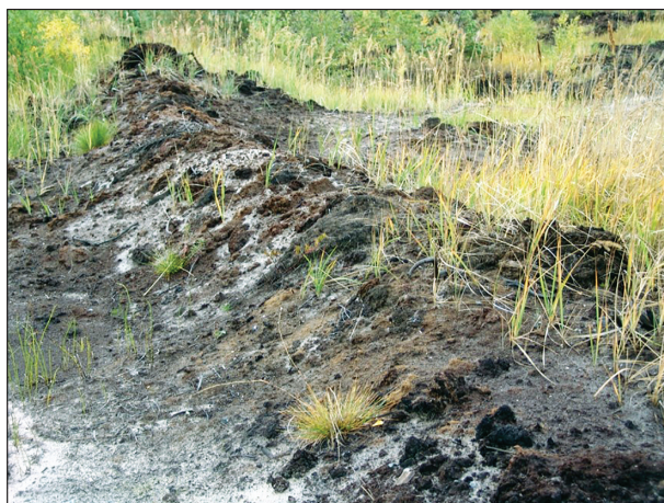
Рис. 2. Насыпной песчаный вал, покрытый торфом, на болоте без трубопровода.
